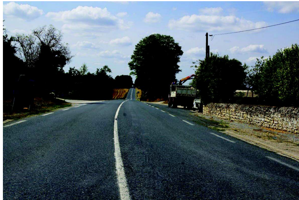
PHOTO 31 : VUE 1 DEPUIS LA D 951 A LA SORTIE OUEST DE CIRON
